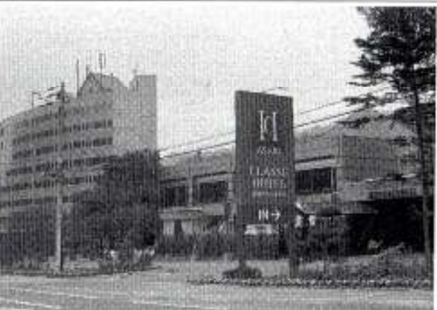
東和の温水ボイラーを導入した小樽朝里クラッセホテル
